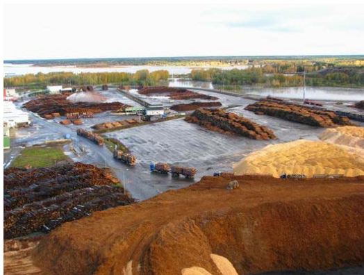
Alholmens Kraft, FIN 240 MW
