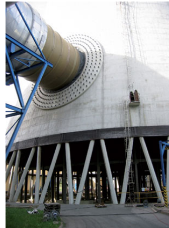
chladicí věž se zabudovaným odvodem spalin z odsíření (Elektrárna Chvaletice)
