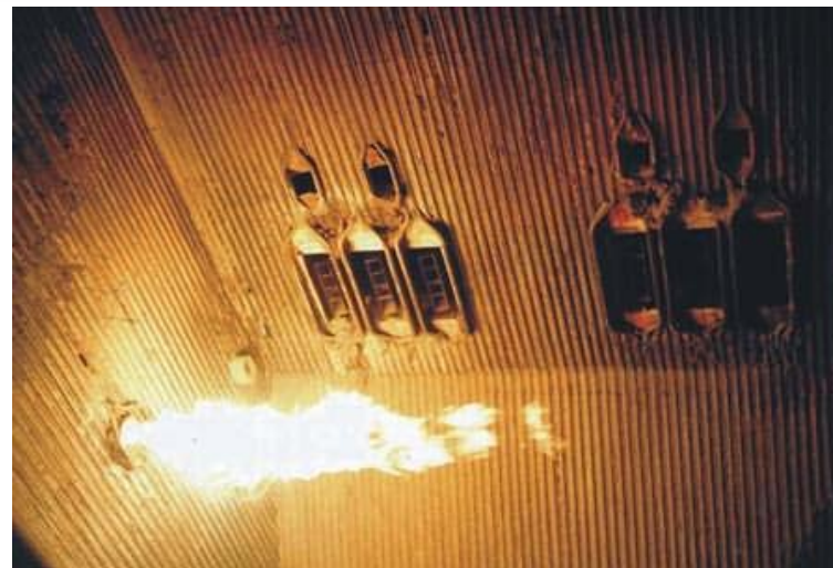
dno spalovací komory granulačního kotle s pom. hořákem LTO
