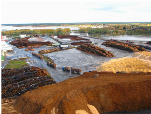
Alholmens Kraft, FIN 240 MW
