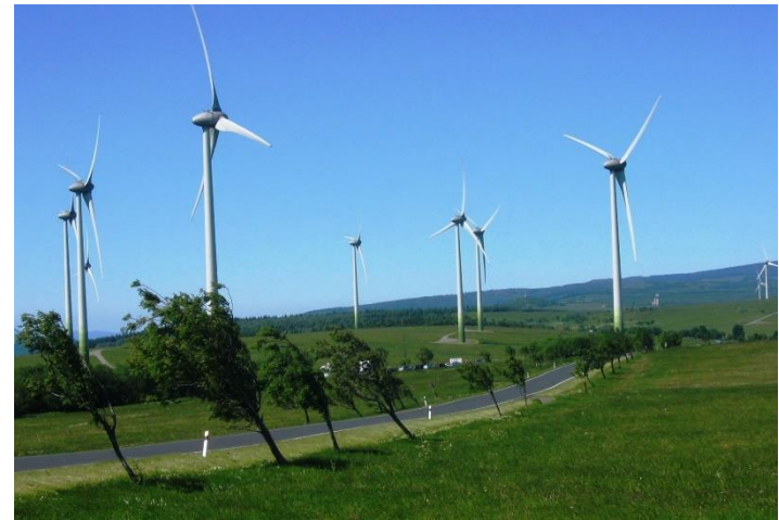
Větrný park Kryštofovy Hamry 42 MW
