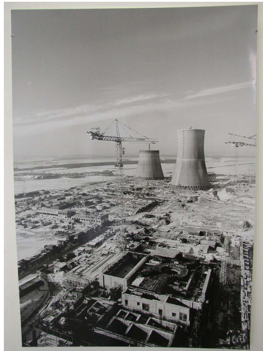
X15PES - 2. Elektrizační soustava
